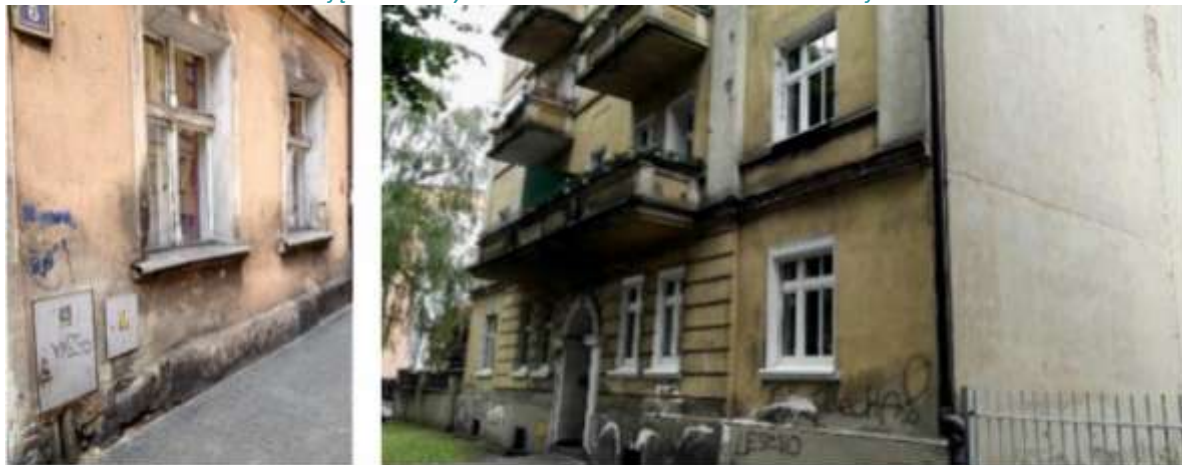
Zdjęcie 5. Budynki mieszkalne w obszarze rewitalizacji.
