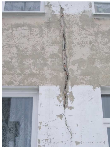
Rysa w tylnej ścianie.
