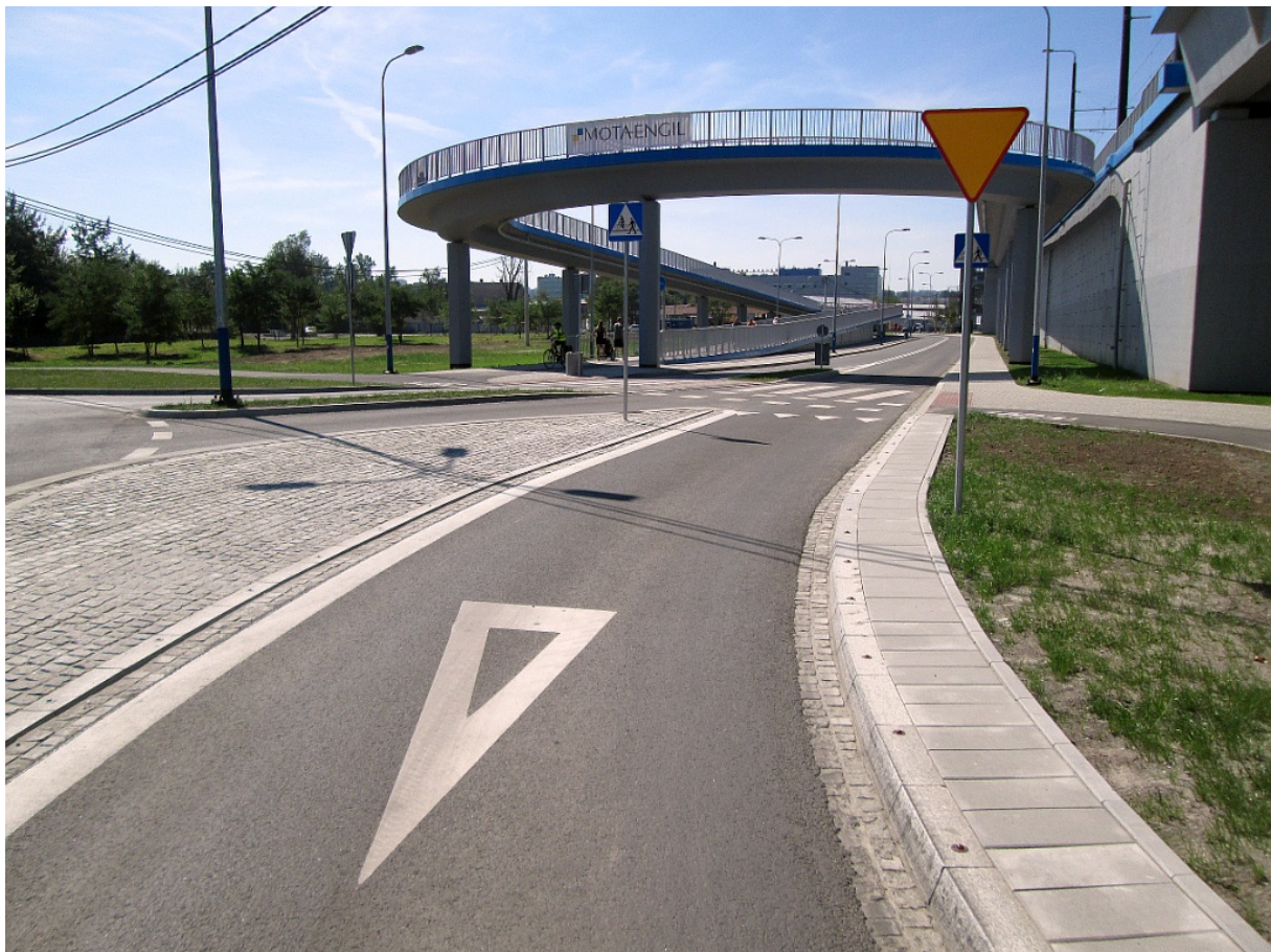
Fot. 12. Poprawne oznakowanie przejazdu dla rowerzystów przecinającego łącznicę („bypass”). Za znakiem poziomym P-15 i pionowym A-7 widać znak D-6b który nie ustala pierwszeństwa i jest jedynie znakiem informacyjnym. Przed przejazdem dla rowerzystów wyznaczono linię zatrzymań złożoną z trójkątów (P-13). Kraków, ul. Saska.
