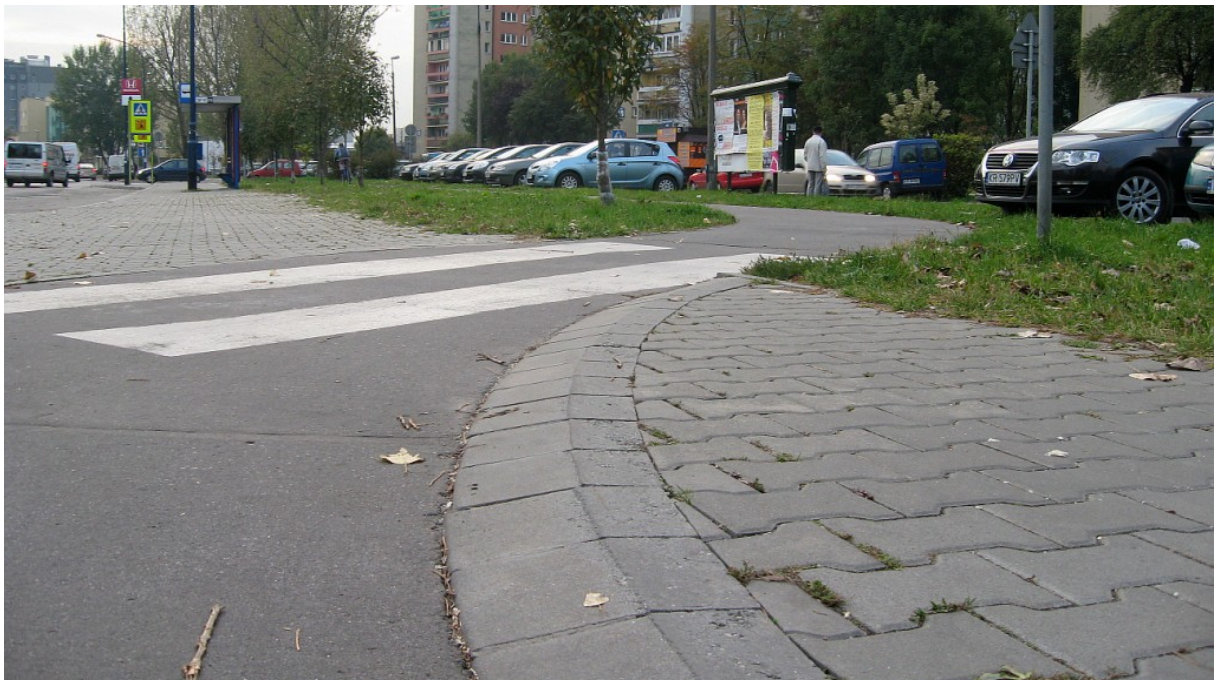
Fot. 5. Prawidłowe oddzielenie drogi dla rowerów od przylegającego chodnika położonym na płasko krawężnikiem drogowym, tworzącym skos ok. 15-30 stopni przy obniżeniu niwelety drogi dla rowerów wobec chodnika o 3-5 cm. Ul. Marii Dąbrowskiej, Kraków.
