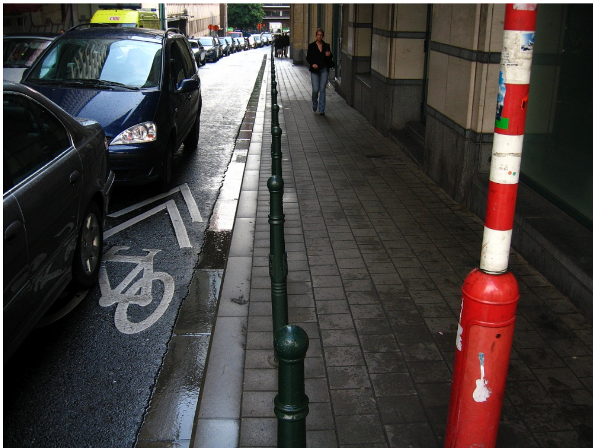
Fot 3. Odpowiednik znaku P-27 „kierunek i tor ruchu roweru” na jezdni ulicy jednokierunkowej otwartej dla ruchu rowerowego w obu kierunkach. Bruksela, Belgia.
