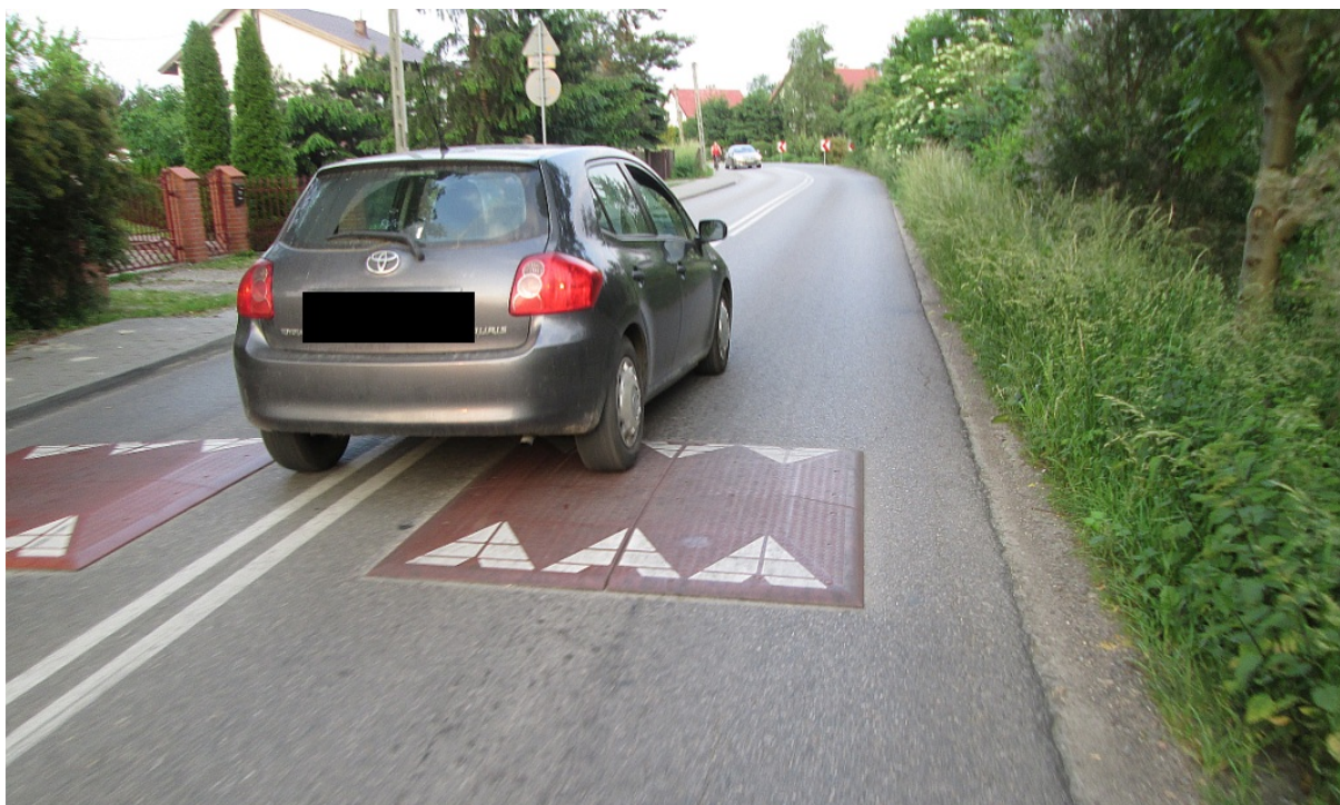
Fot. 2. Przykład uspokojenia ruchu przy pomocy prawidłowo umieszczonych progów wyspowych (niemożliwe jest ominięcie progów samochodem przez jazdę środkiem jezdni – widoczny na zdjęciu pojazd przekracza linię P-4, bo wcześniej wyprzedzał rowerzystę). Piekary koło Krakowa.
