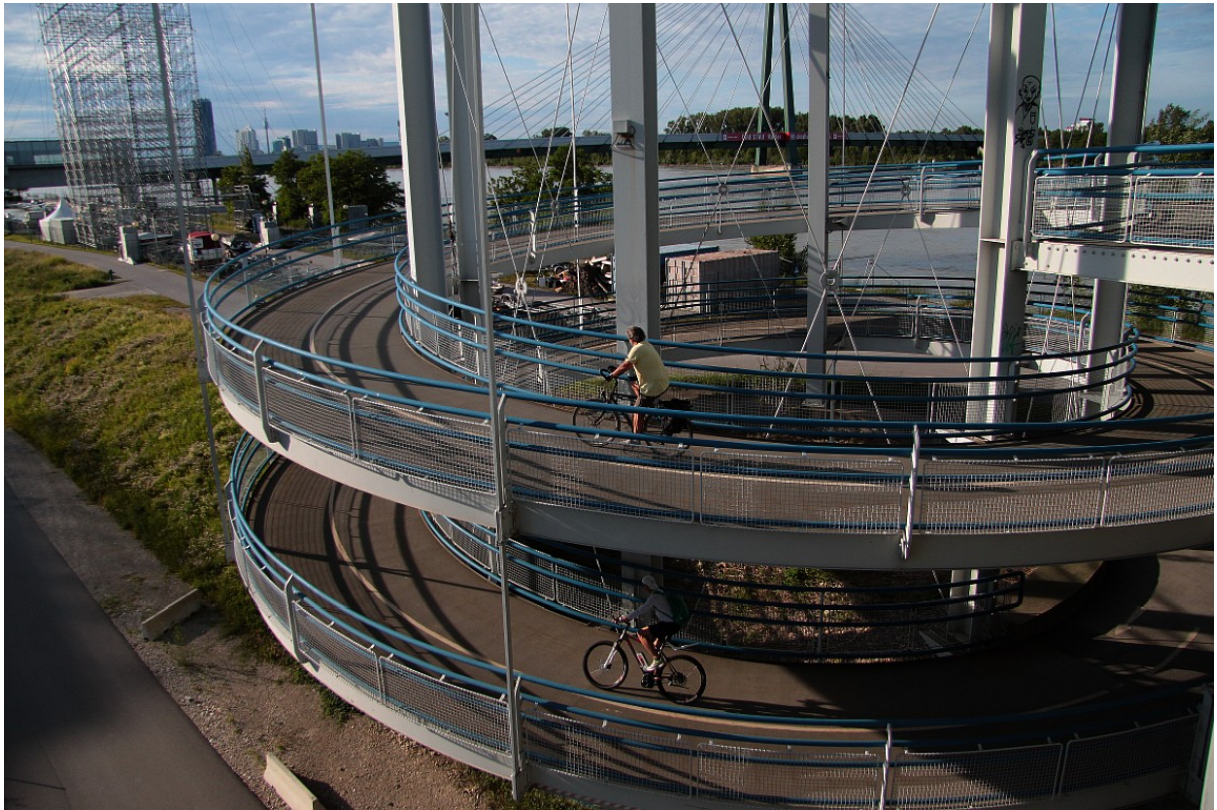
Fot. 13. Pochylnia ślimakowa prowadząca z brzegu Dunaju na drogę dla rowerów zlokalizowaną w dolnym poziomie mostu Praterbrücke. Widoczna prawidłowa orientacja pochylni: w lewo w dół, zapewniająca większy promień łuku rowerzystom jadącym z większą szybkością w dół i minimalizująca ryzyko kolizji. Zwraca uwagę wysoko umieszczona barieroporęcz. Wiedeń, Austria.
