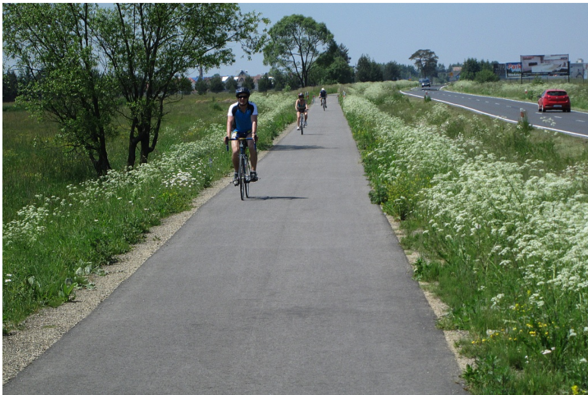
Fot. 6. Droga dla rowerów o nawierzchni asfaltowej wykonana na poszerzonej podbudowie, bez zbędnych i podnoszących koszty obrzeży lub krawężników. Droga wojewódzka nr 957, fragment trasy rowerowej euroregionu Tatry Nowy Targ – Sucha Hora/Trstena (Słowacja).
