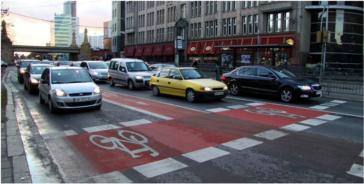
Fot. 8. Śluza klasyczna (typu 1), ul. Świdnicka, Wrocław.
