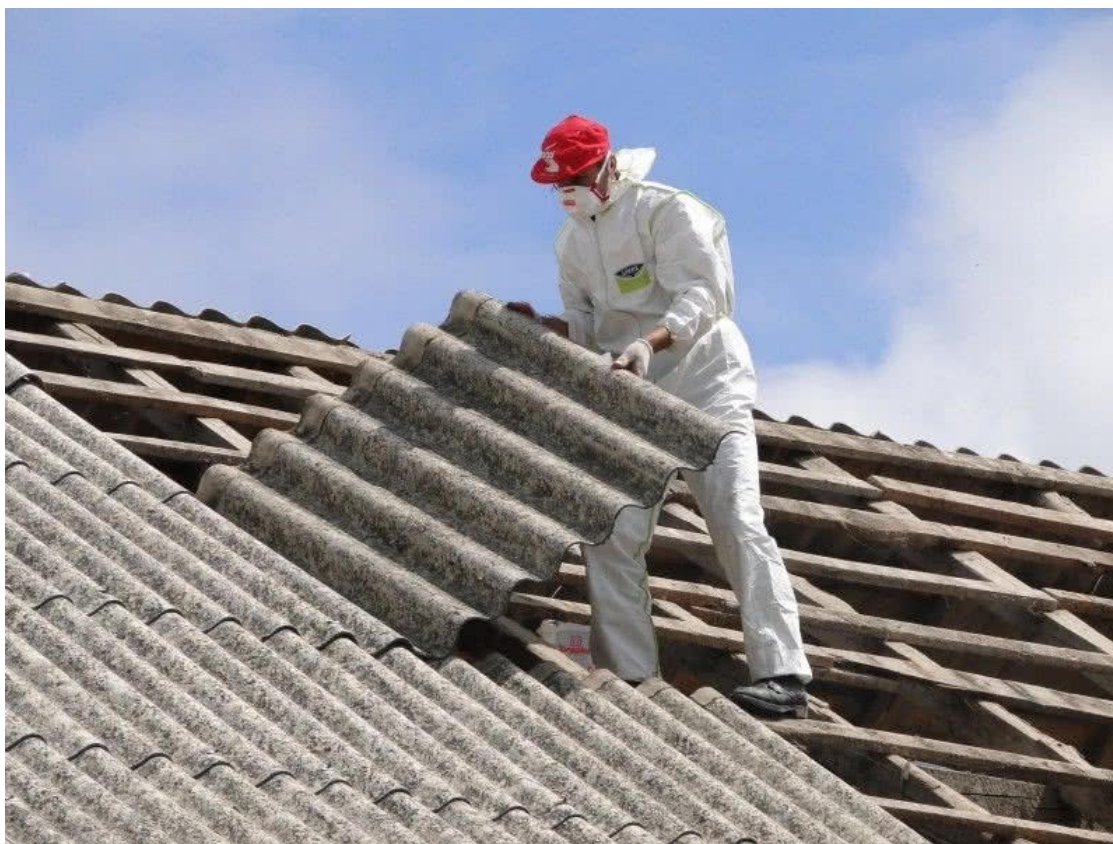
Rysunek 1 Wyroby azbestowe wykorzystywane jako pokrycie dachowe budynków Źródło: zdjęcie autora
