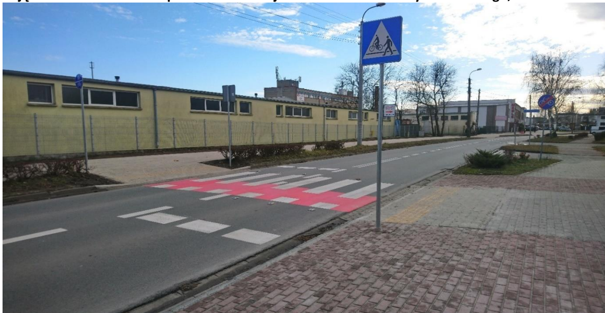
Zdjęcie 10 Budowa ścieżki pieszo rowerowej od ul. Okrzei do ul. Szymanowskiego, Leszno
