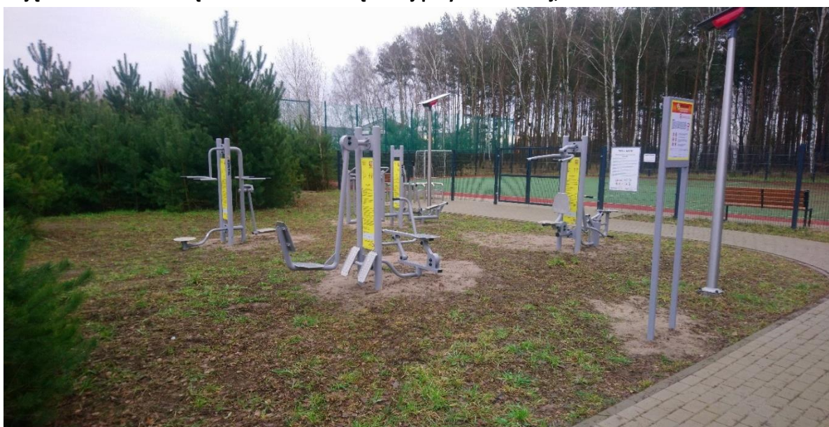
Zdjęcie 11 Montaż urządzeń siłowni zewnętrznej przy ul. Siewnej, Leszno
