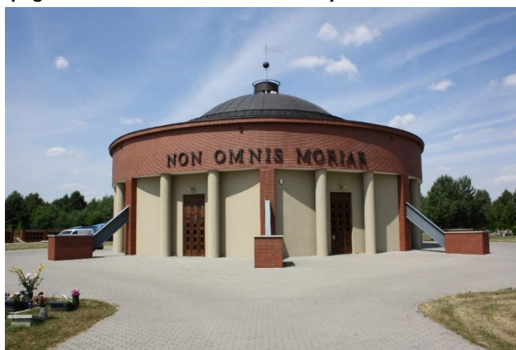
Zdjęcie 16 Kaplica pogrzebowa na cmentarzu komunalnym w Lesznie
