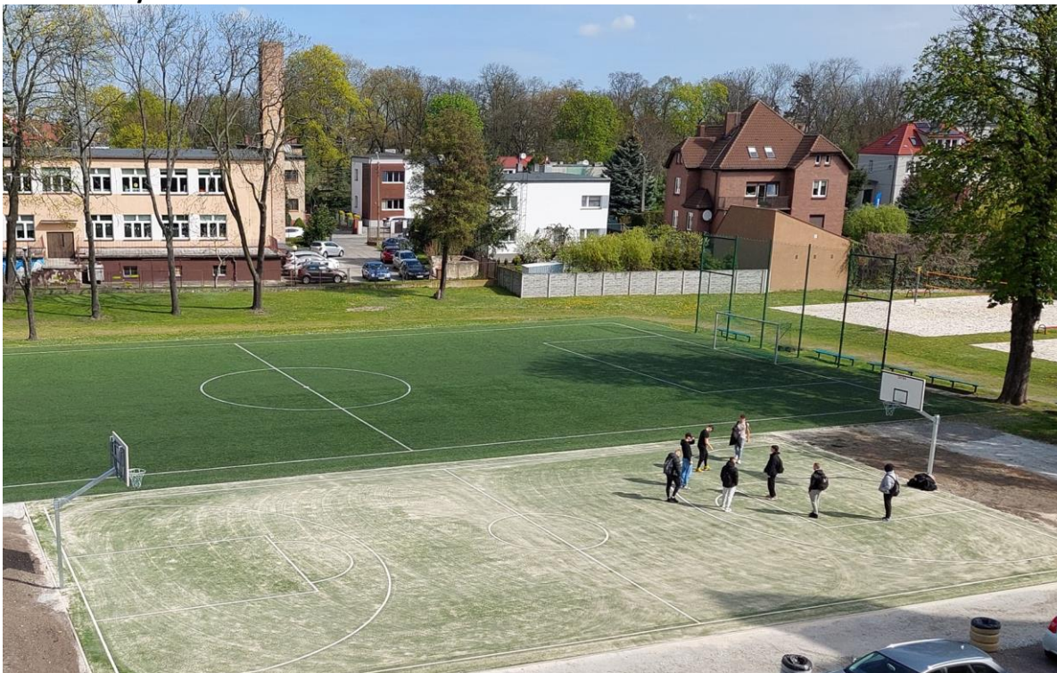
Zdjęcie 14 Budowa ogólnodostępnego boiska do koszykówki na terenie Zespołu Szkół Ekonomicznych w Lesznie
