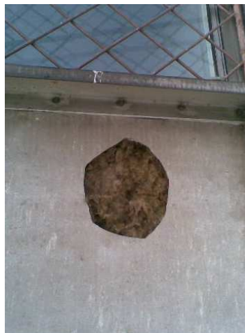
Elewacja warstwowa (szkło hartowane, pustka powietrzna, płyta azbestowo-cementowa, wełna mineralna) (Ministerstwo Gospodarki, 2007)
