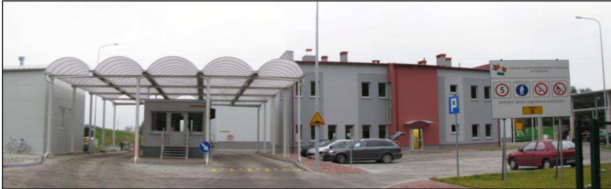
Rysunek 2.27 Widok ogólny Zakładu – wjazd, moduł ważenia, budynek administracyjny – fot. proGEO
