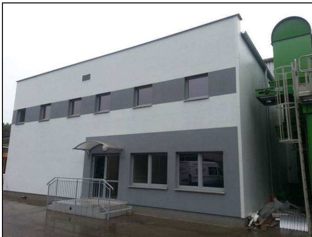
budynek zaplecza socjalnego
