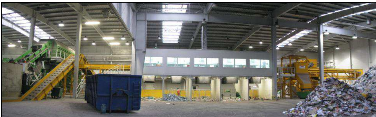
Rysunek 2.28 Hala technologiczna segregacji odpadów – fot. proGEO
