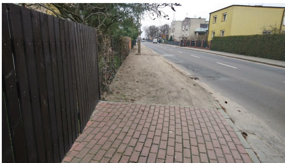
Zdjęcie 22 Remont chodnika przy ul. Stanisława Szczepanowskiego w Lesznie
