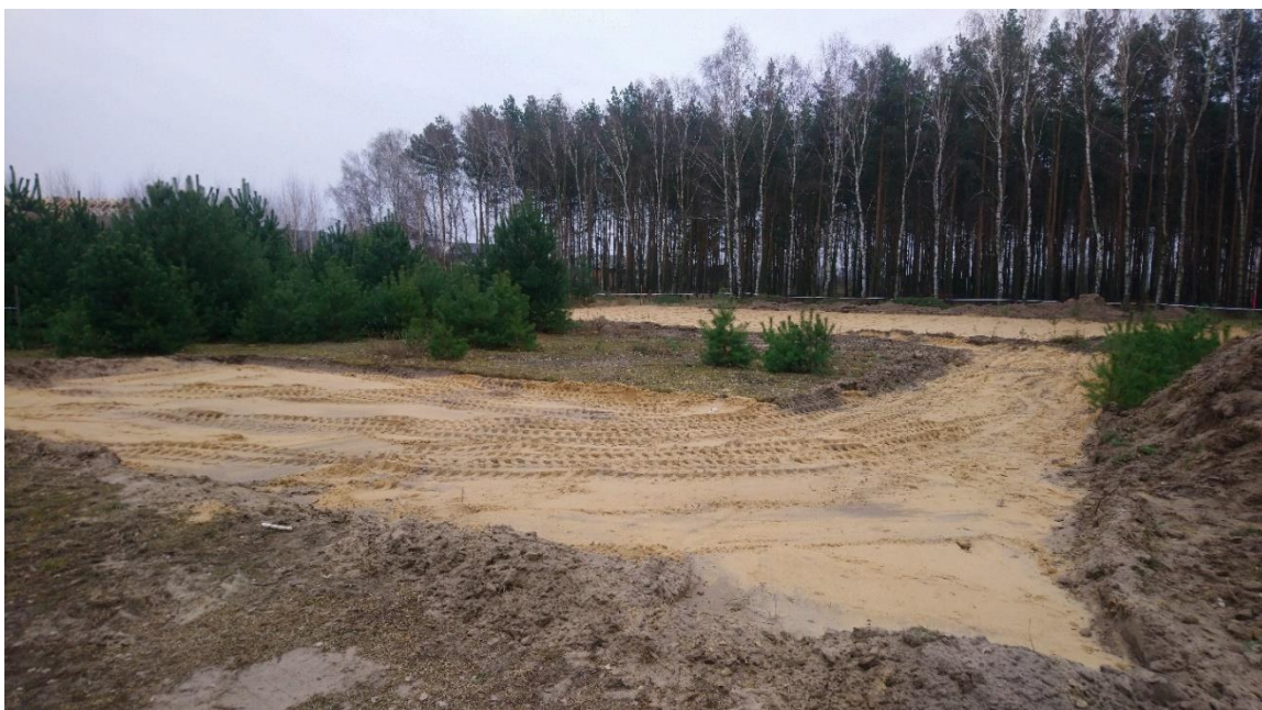
Zdjęcie 17 Etap budowy boiska wielofunkcyjnego przy ul. Siewnej w Lesznie
