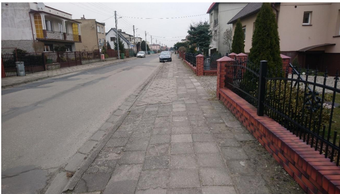
Zdjęcie 18 Etap budowy chodnika przy ul. Mikołaja Reja w Lesznie
