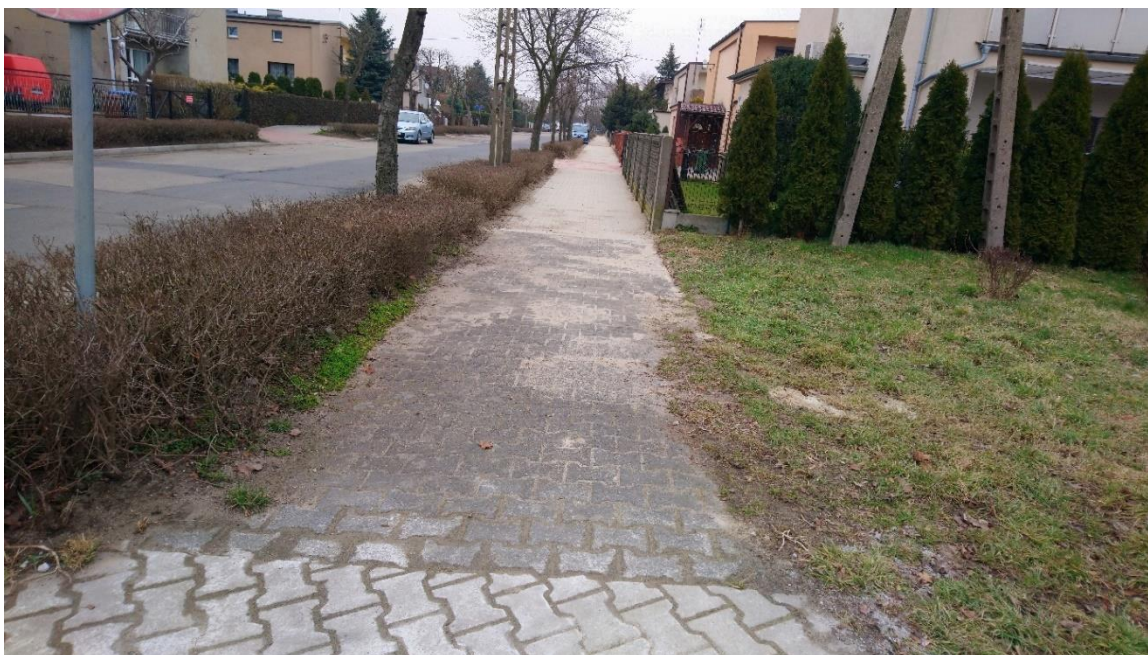
Zdjęcie 19 Etap budowy chodnika przy ul. Lubuskiej w Lesznie
