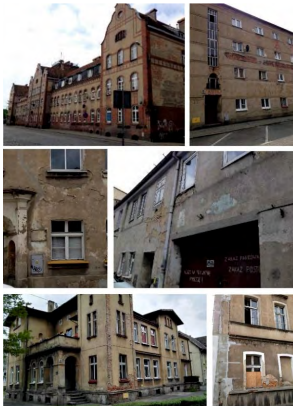
Zdjęcie 7. Budynki mieszkalne w obszarze rewitalizacji
