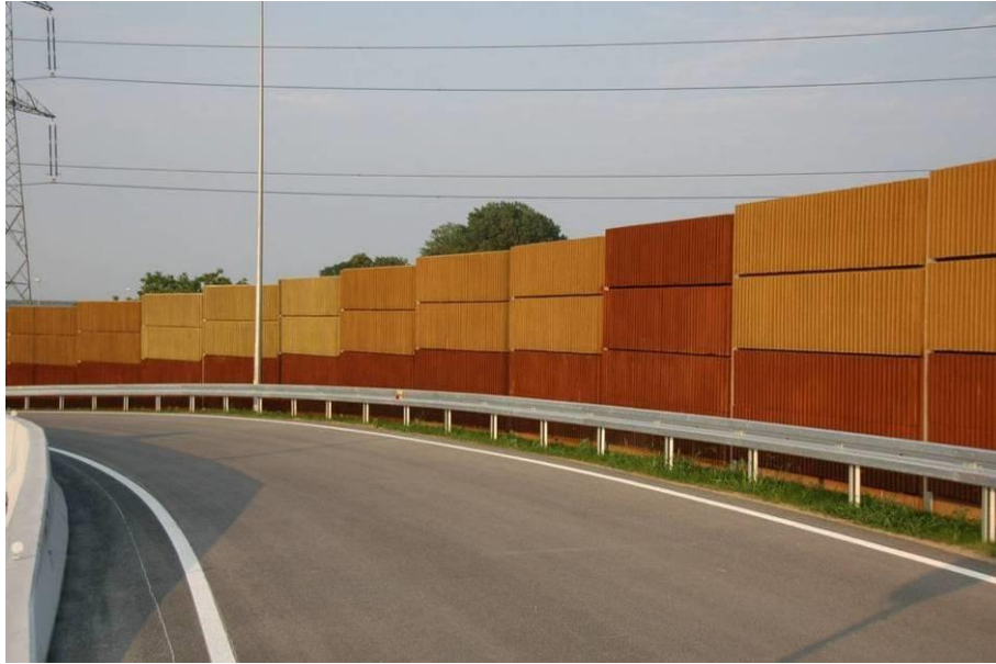
Rys. 17. Ekran przeciwhałasowy (betonowy)
