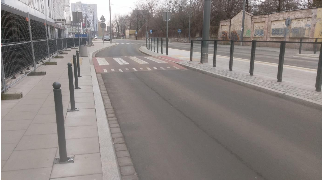
Rys. 12. Przykład wyniesionego przejścia dla pieszych (materiały własne)
