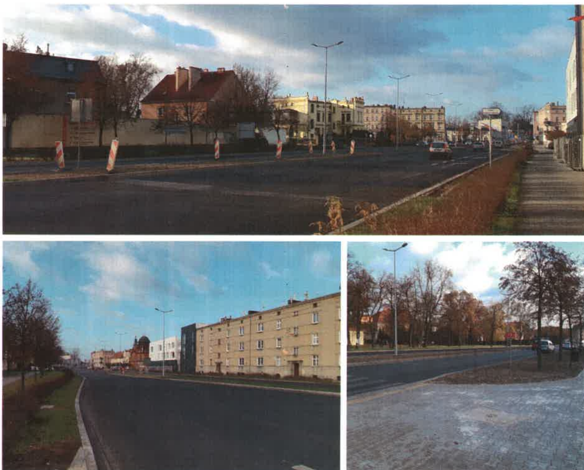
Zdjęcie 4 Przebudowa drogi krajowej 12 w granicach miasta
