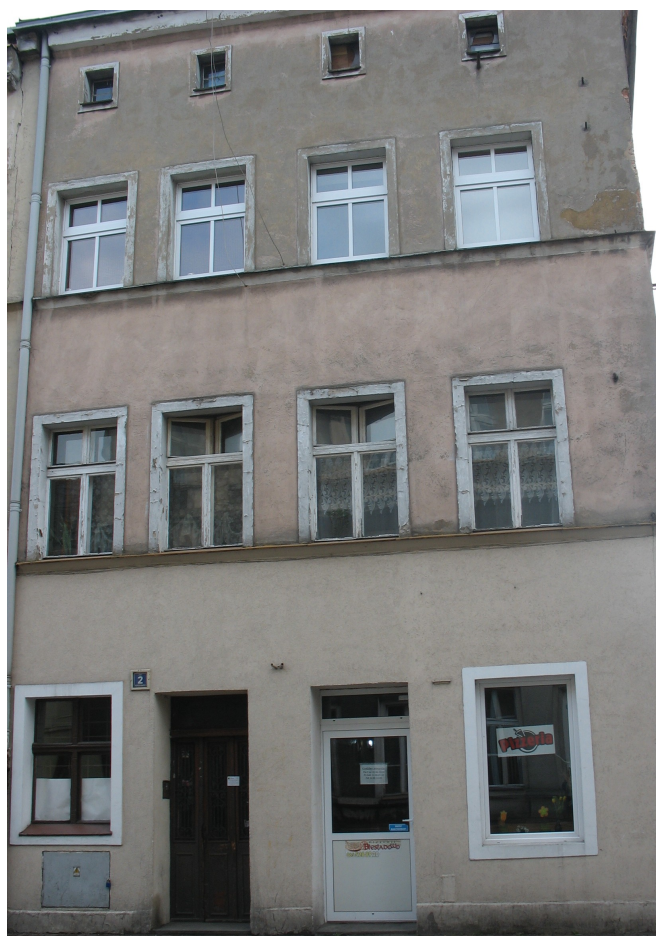
Elewacja frontowa – północna
