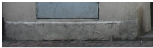
cokół elewacji frontowej
