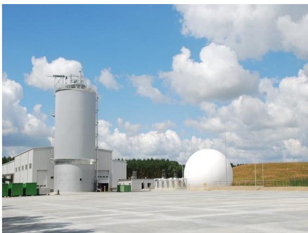
Rys. 32. Hala suchej fermentacji, komora fermentacyjna, zbiornik biogazu źródło: www.mzoleszno.com.pl
