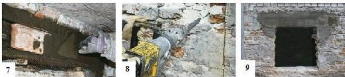
Rys. 14. Przykładowy sposób wykonania nadproża z zastosowaniem belek stalowych (materiały pochodzą z bazy strony muratordom.pl)
