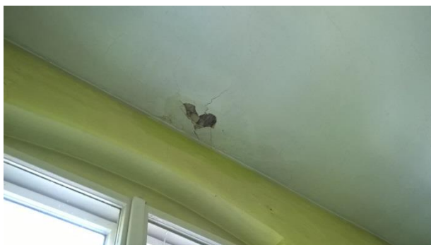
Fot. 28. Stan wykończenia pomieszczeń 2 piętra. Miejscowe ubytki tynku.
