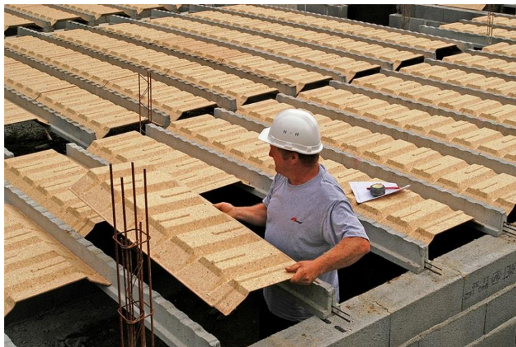
Rys. 3. Montaż elementów stropu gęstożebrowego.
