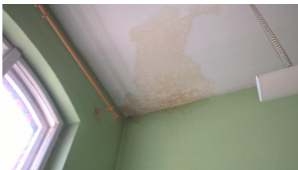
Fot. 30. Zawilgocenie stropu nad 2 piętrem.
