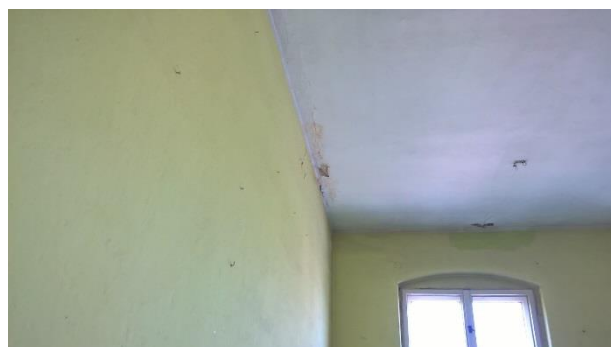
Fot. 27. Stan wykończenia pomieszczeń 2 piętra. Miejscowe ubytki tynku.
