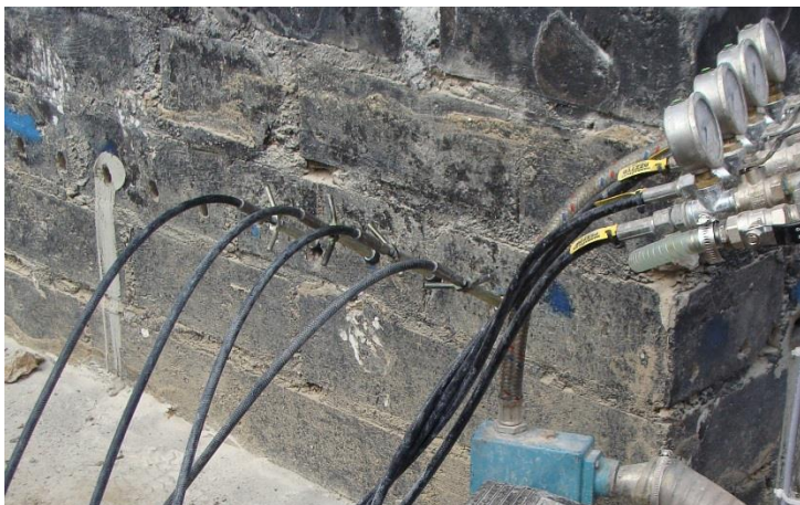
Rys.15. Iniekcja ciśnieniowa.
