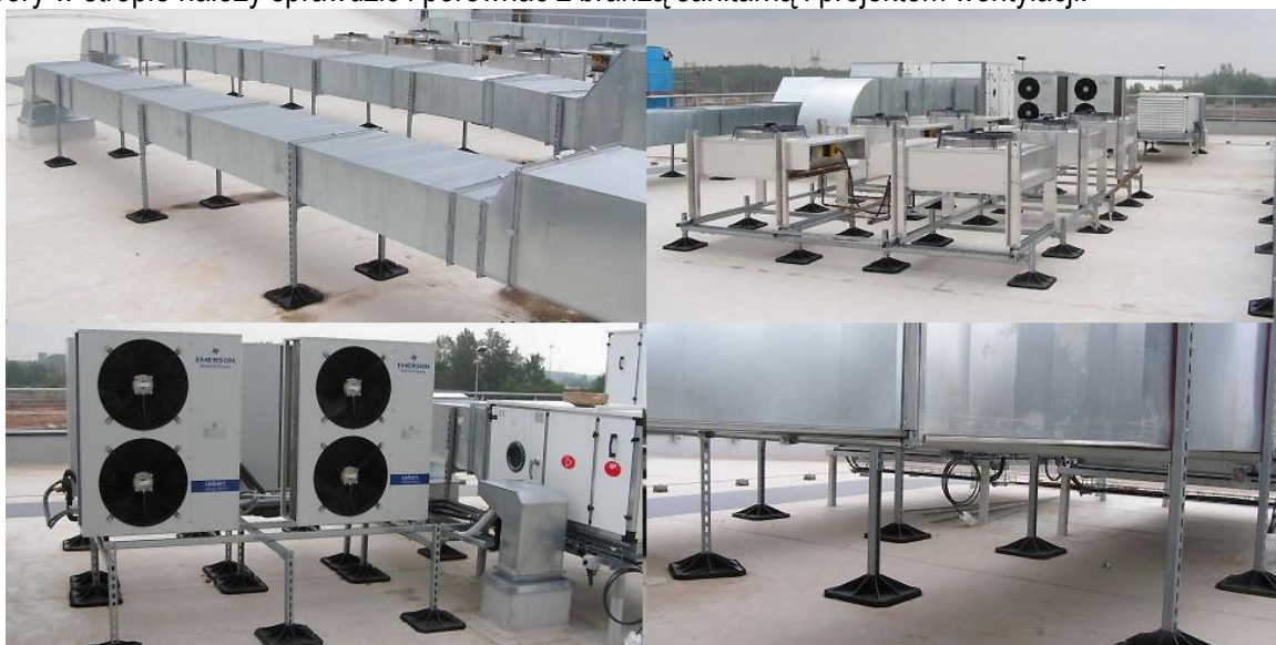
Rys. 19. Przykładowe systemowe konstrukcje wsporcze pod centrale wentylacyjne.
