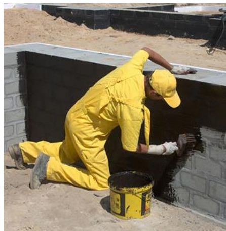
Rys.16. Wykonanie izolacji pionowej.
