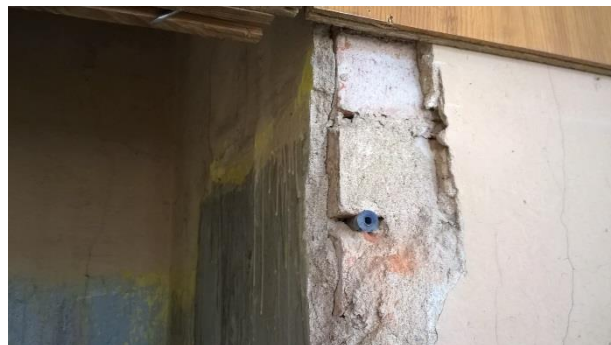
Fot. 23. Miejscowe ubytki tynków.
