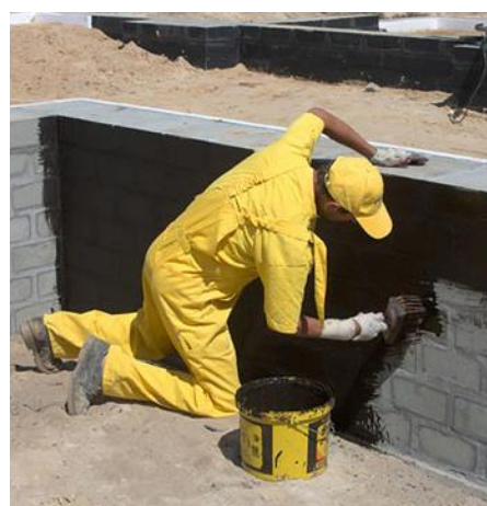
Fot. 39. Wykonanie izolacji pionowej.
