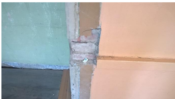
Fot. 24. Miejscowe ubytki tynków.
