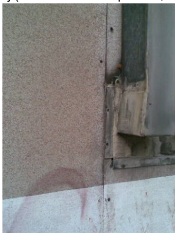
Elewacja z płyty azbestowo-cementowej - prasowana płaska okładzinowa (Ministerstwo Gospodarki, 2007)
