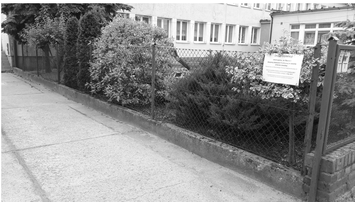
Płot wraz z podmurówką do demontażu. Zielen bez zmian.
