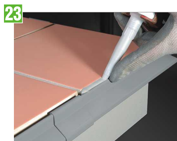
23 Wypełniamy szczeliny elastyczną masą uszczelniającą (do stosowania na zewnątrz, np. poliuretanową).
