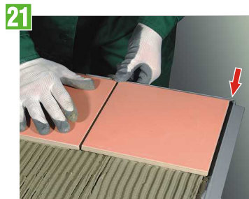
21 Układamy płytki pozostawiając szczelinę pomiędzy czołem profilu a płytkami o szer. 6 mm
