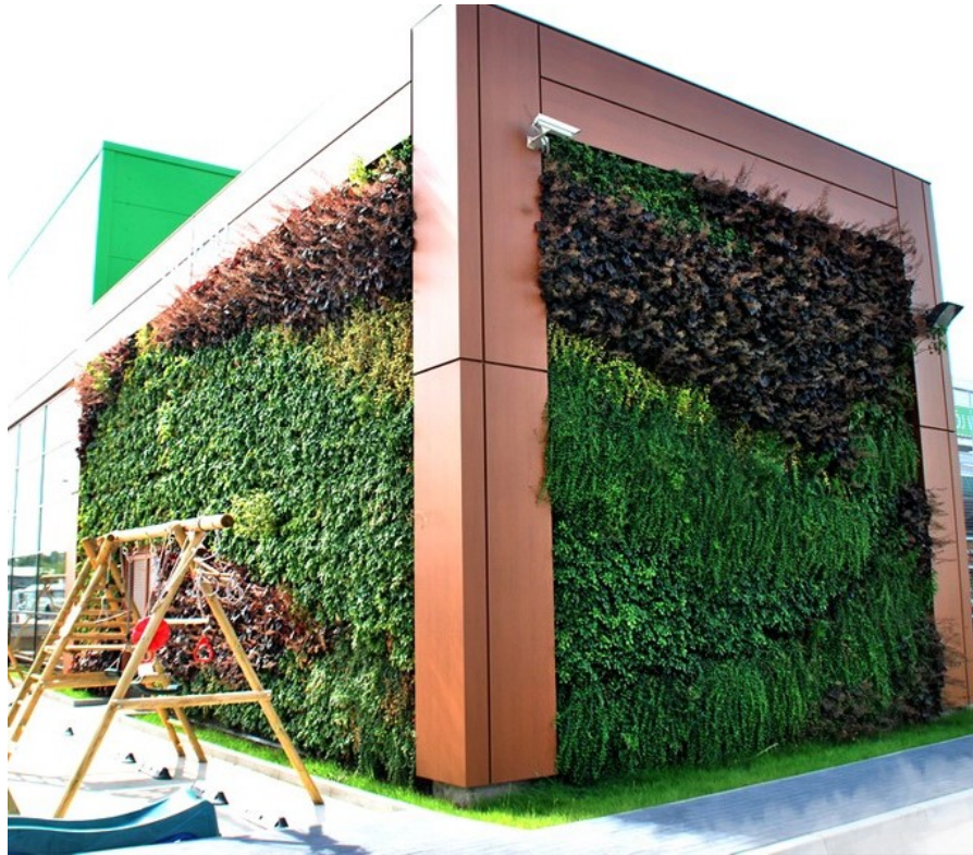
Rysunek 53. Zielona ściana w jednym z podpoznańskich marketów budowlanych
